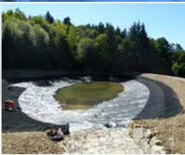
standard normativi vigenti. Gli interventi effettuati hanno riguardato in particolare l'impermeabilizzazione dell'invaso, la modellazione e il ricarico del coronamento, la realizzazione di un nuovo sifone-scarico di fondo e, infine, l'adeguamento dello scarico di superficie con la creazione di un canale fugatore.
